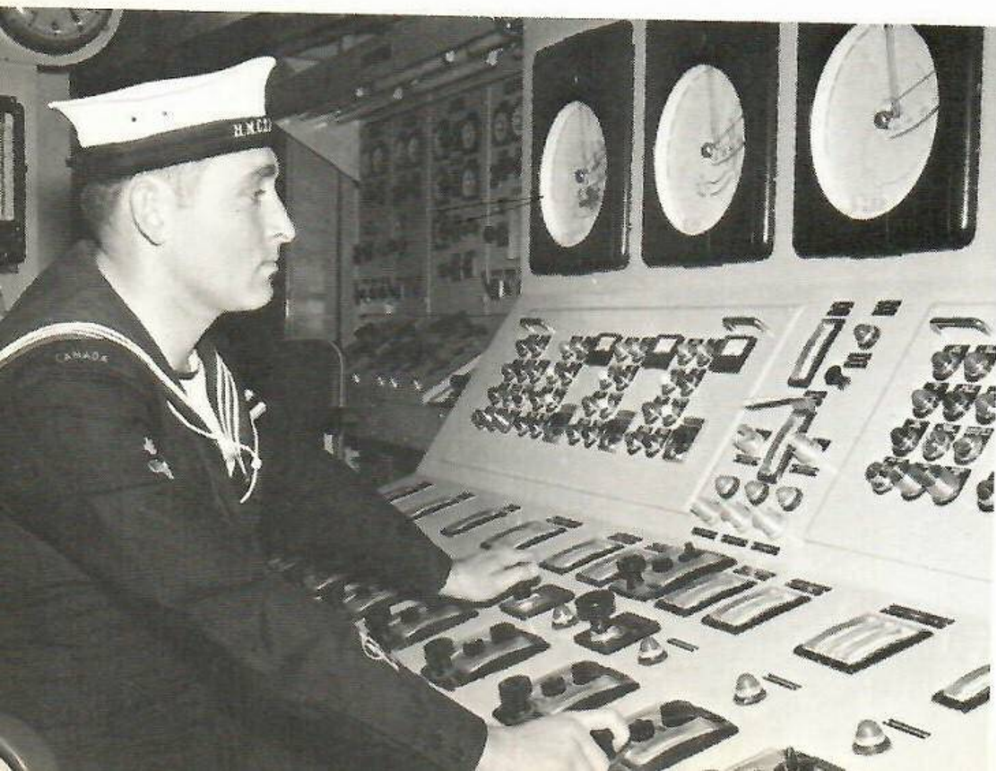
Poste de commande des machines
